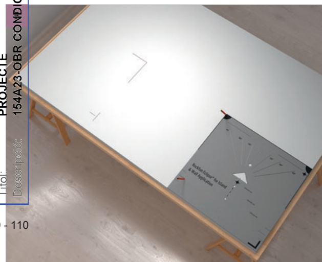
Coloque la plantilla en la esquina inferior derecha de la parte trasera del absorbente mural Rockfon Eclipse. Con un lápiz, marque las líneas centrales, utilizando la esquina superior izquierda de la plantilla y la posición del espaciador. Vea 5 - Resultado.
