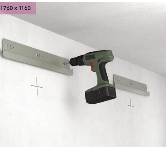
Perfore la pared e instale el soporte de fijación de pared.
