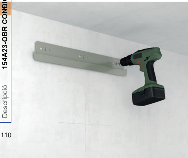
Perfore la pared e instale el soporte de fijación de pared.
