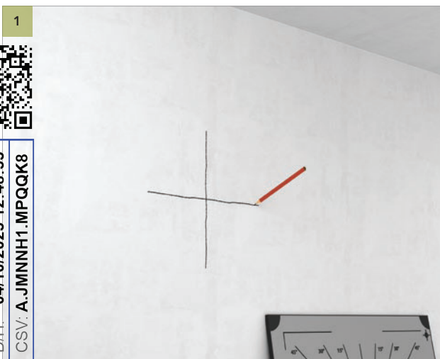
1 Marque una cruz en la pared para indicar donde está previsto fijar el centro del absorbente mural Rockfon Eclipse. Asegúrese de que el trazo superior de la cruz sea de +/- 30 cm
