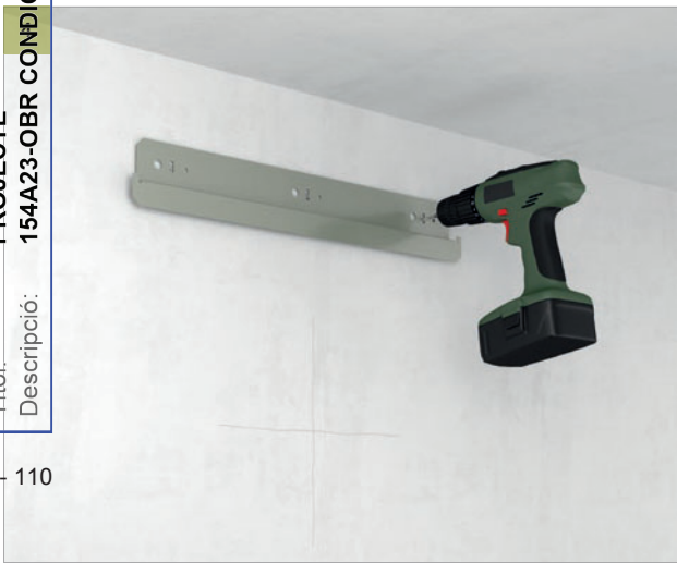
6 Perfore la pared e instale el soporte de fijación de pared.
