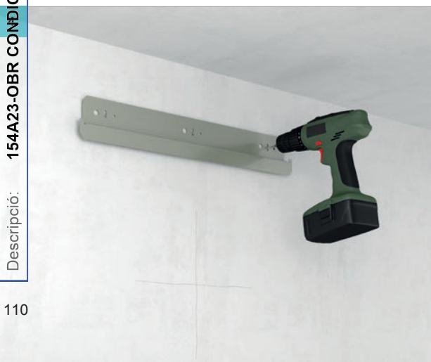
Perfore la pared e instale el soporte de fijación de pared.
