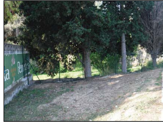
Foto 2: Zona del mur caigut.
