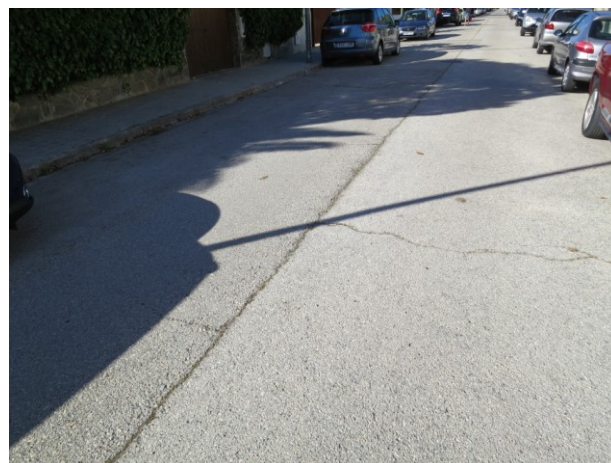
Localització i Detall d'asfalt en mal estat
