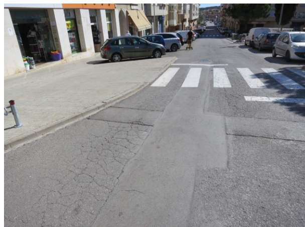
Vista del pas de vianants de la plaça Francesc Layret. Detall del mal estat de l'asfalt
