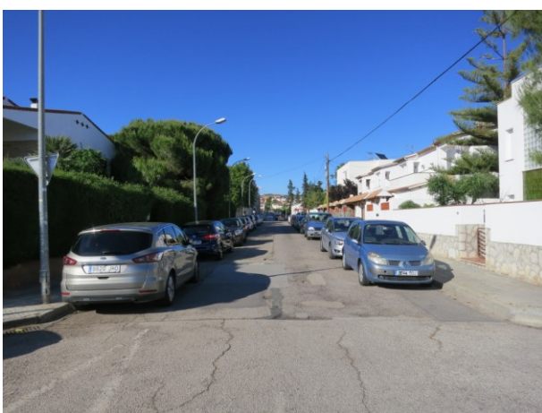
Detall d'asfalt en mal estat.
