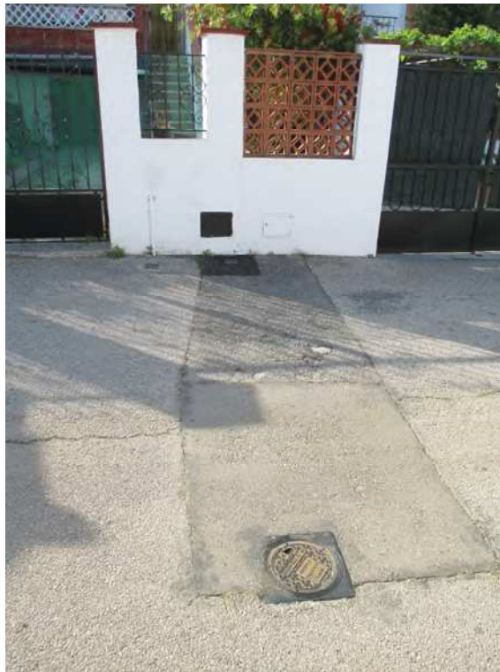
Fotografia 5. Vista de la escomesa d'un habitatge del C/Juan Miró a renovar.
