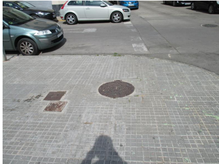
Fotografia 5. Vista exterior de la arqueta a demolir al carrer Murillo.
