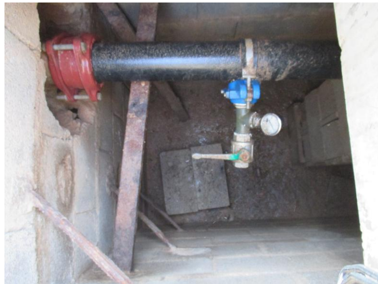
Fotografia 6. Vista interior de la arqueta a demolir al carrer Murillo.
