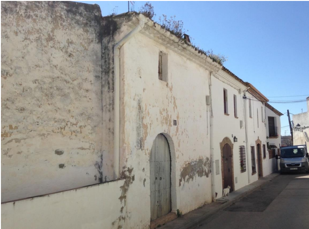
Façana a carrer Palou
