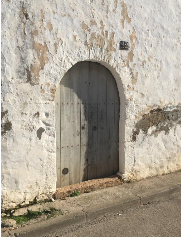
1. Portal amb arc de mig punt
