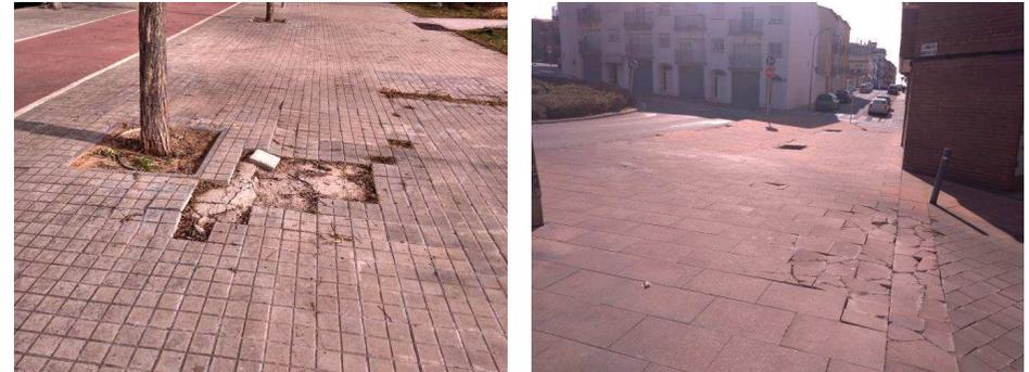
Figura 2: Hundimiento localizado
