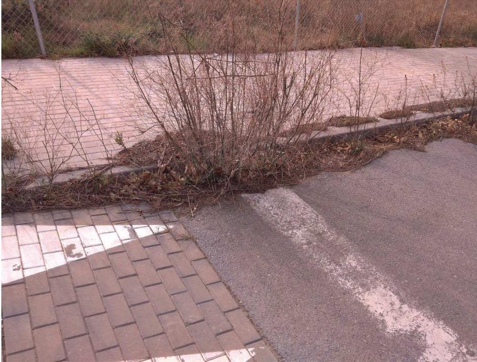
**Figura 4: Crecimiento de vegetación en junta rigola**
