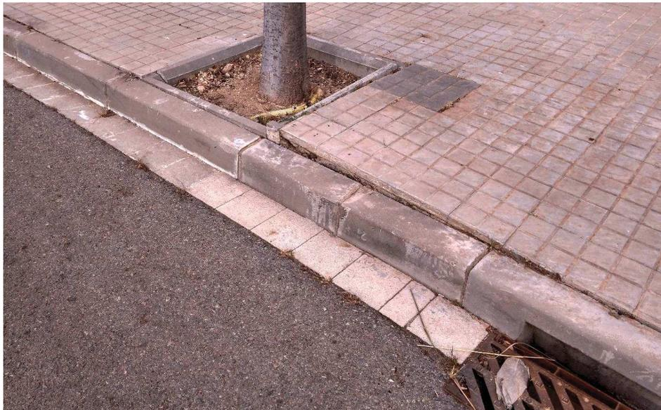
Figura 1: Levantamiento de aceras por raíces
