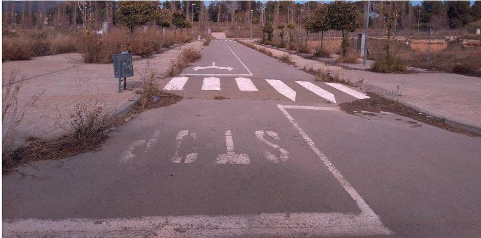
Figura 1: Paso de peatones elevado sin señales y estado de marcas viales deteriorado
