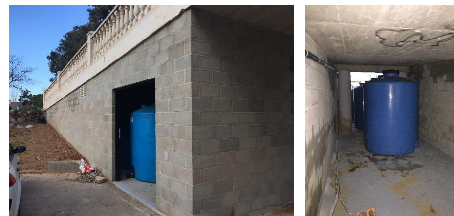
4. Estat actual sala de instal·lacions.
