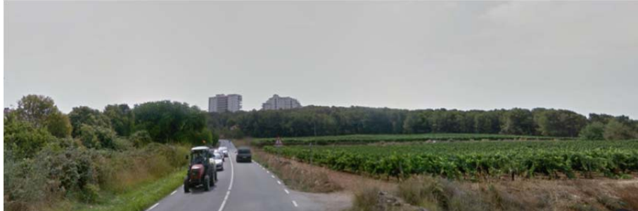
Carretera C-2111 a l'alçada del camí actual de l'entrada nord de l'Autòdrom de Terramar
