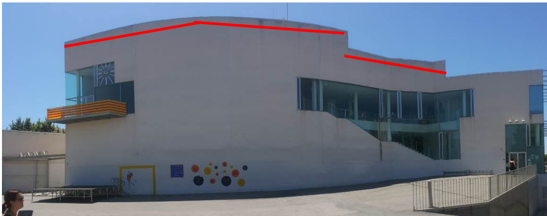
Nova línia de vida (per l'interior del mur en planta coberta)
