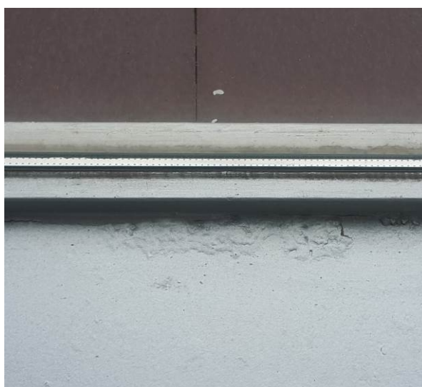
Grau B – Platina amb inici de procés d'oxidació
