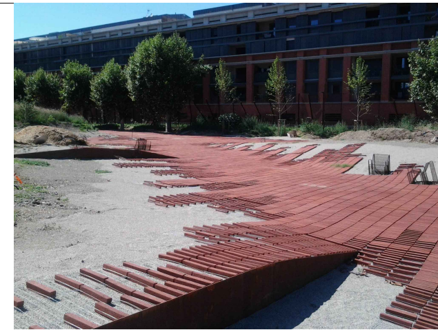
TEIXIT CERÀMIC: Sistema industrialitzat basat en làmines flexibles per la creació de revestiments y estructures laminars
