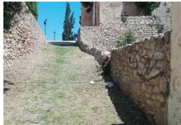
Fig.7: Mur del camí deformat
