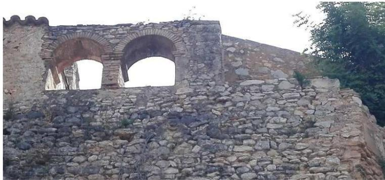
Fig.6: Esquarteres en el mur provocades per arrels d'arbres
