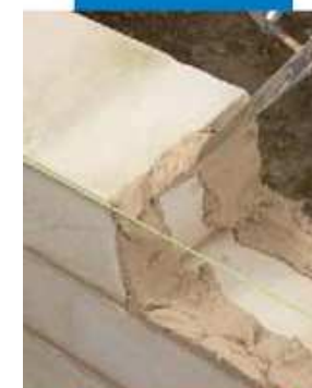
Aplicación de Mape-Antique Allettamento
