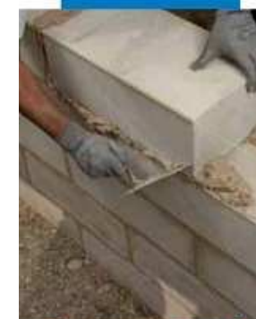
Eliminación del mortero en exceso
