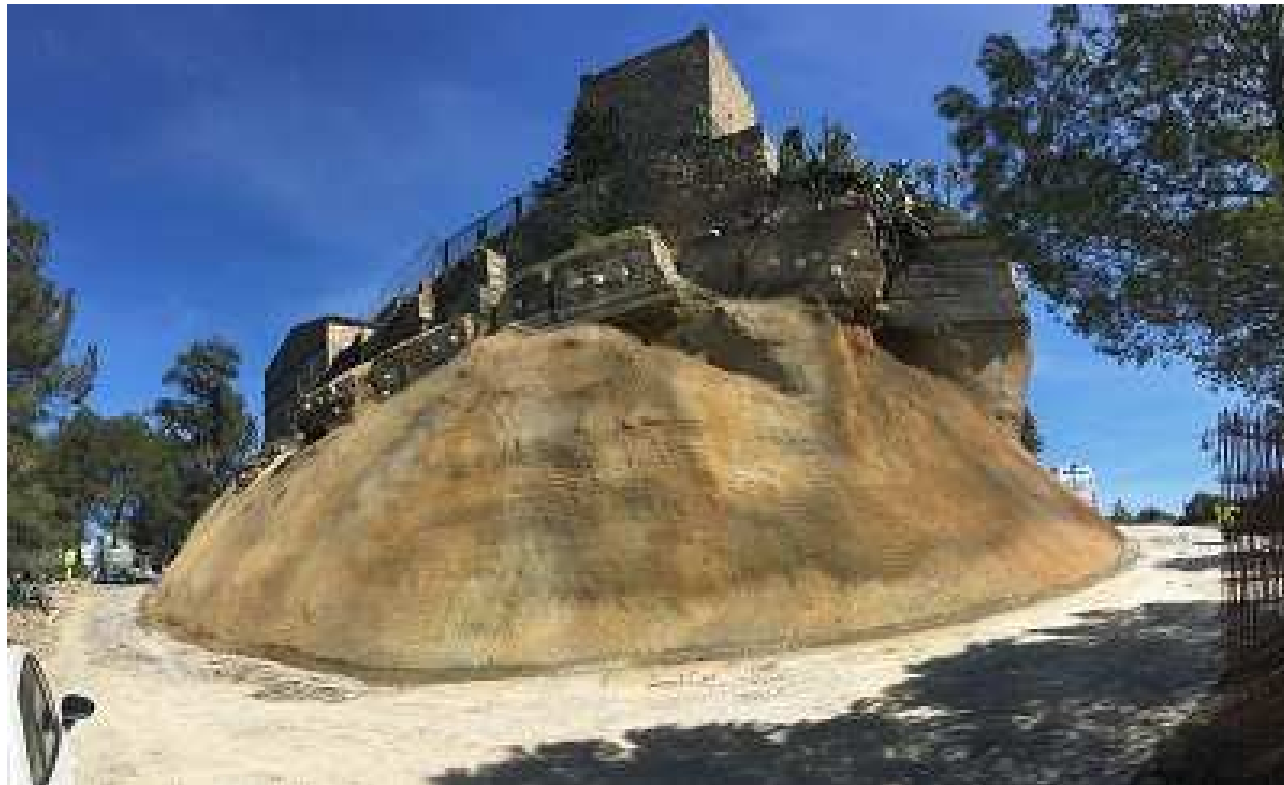
Pintat amb solucions aquoses d'òxids per obtenir un color terrós
