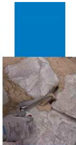
Retacado de las juntas de un muro de albañilería de piedra
