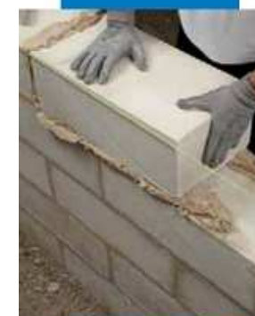
Colocación de bloque de piedra de Lecce
