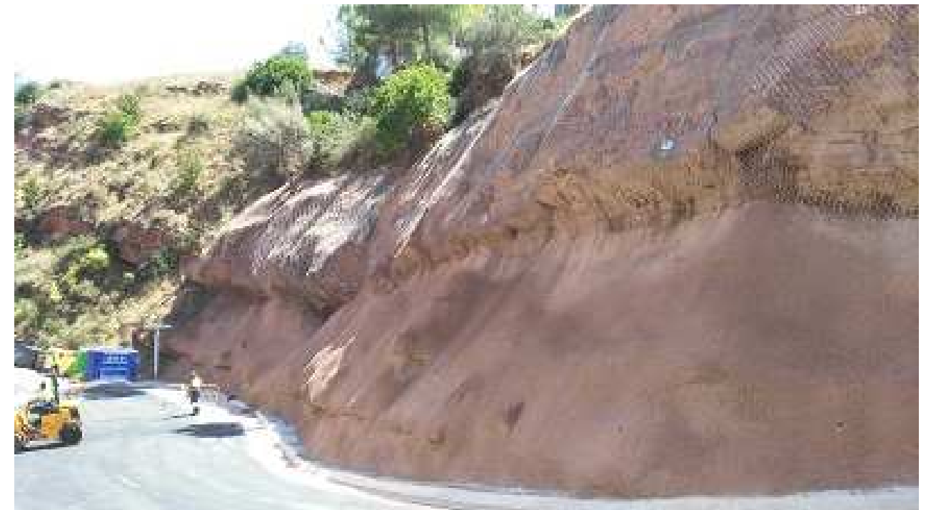
Color aconseguit amb tints incorporats al formigó amb el color i to segons la necessitat
