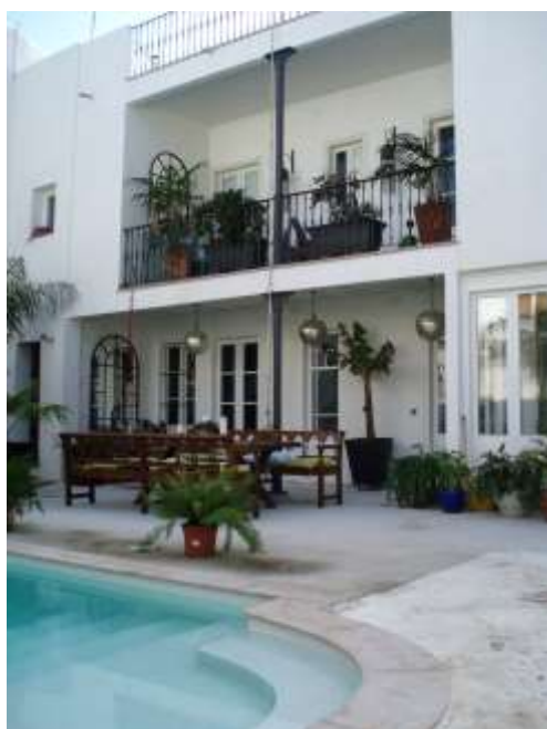
Façana posterior austera, amb galeries centrals i baranes de ferro
