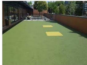
Paviment cautxú continu.
