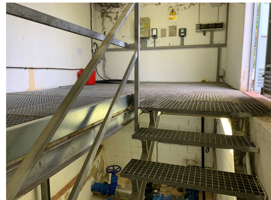
Figura 1: Fotografies del dipòsit de Palou
