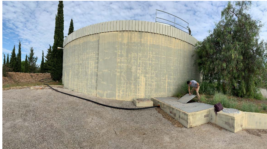
1. Dipòsit Palou. Exterior
