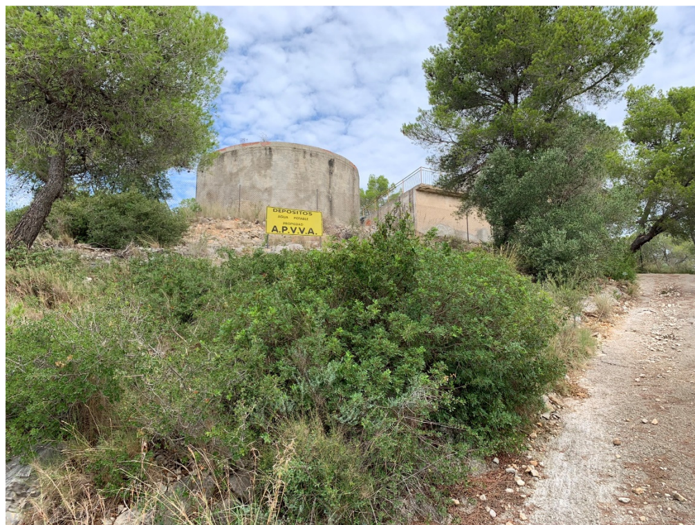
Figura 2: Imatge del dipòsit de Can Lloses
