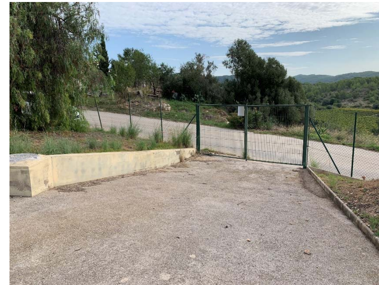
3. Dipòsit Palou. Entrada
