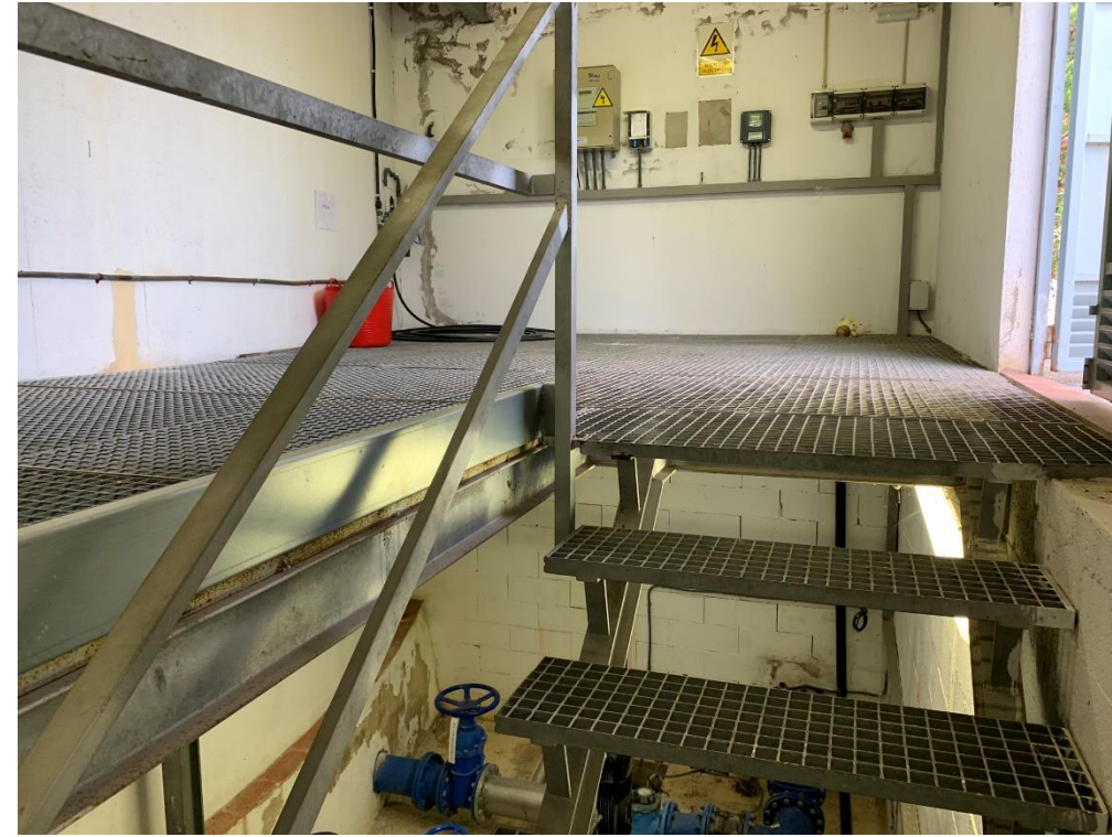
Figura 2: Fotografies del dipòsit de Palou
