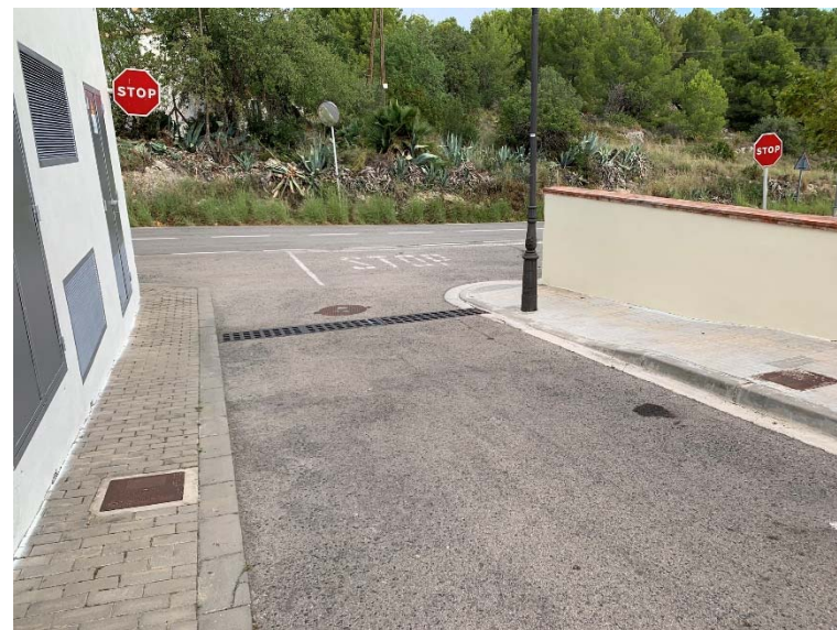
6. Creuament del carrer Gala Plàcidia amb la carretera BV-2111
