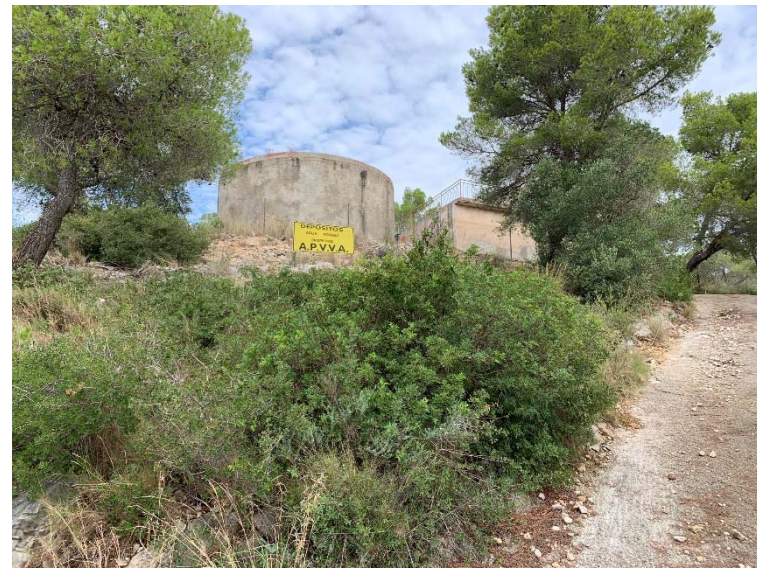
14. Dipòsit de Can Lloses. Exterior
