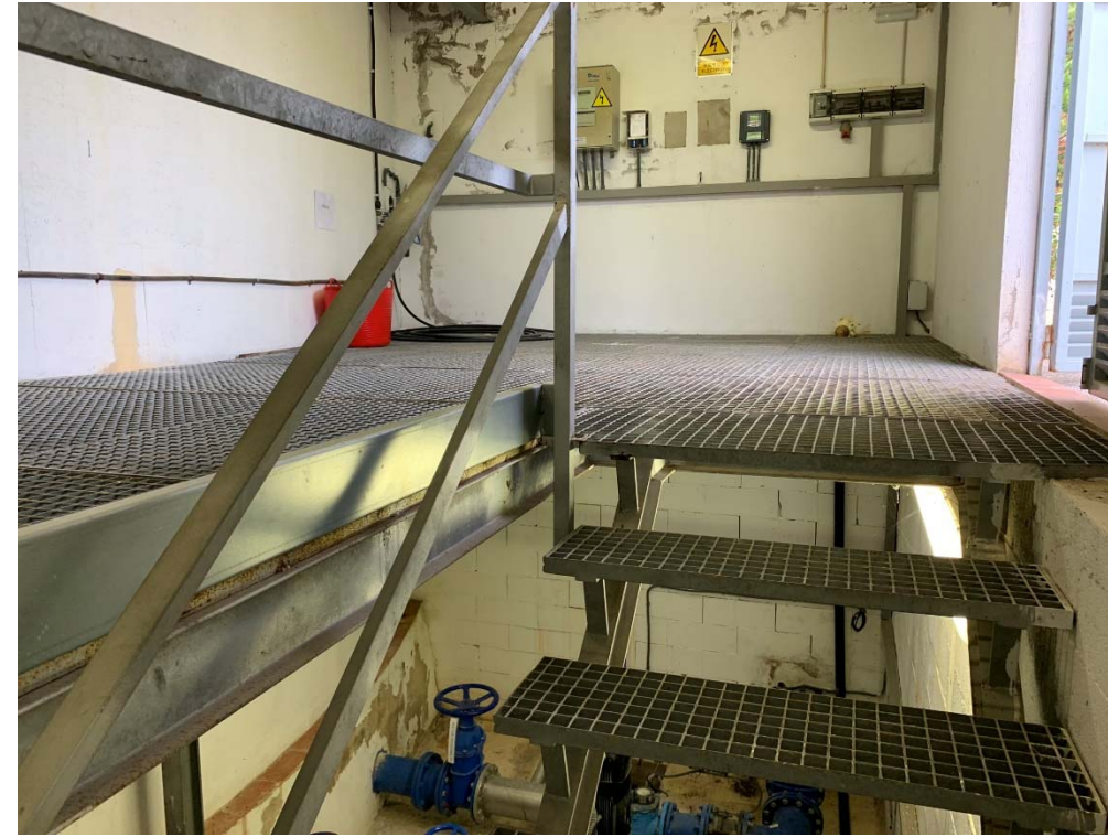
Figura 2: Fotografies del dipòsit de Palou
