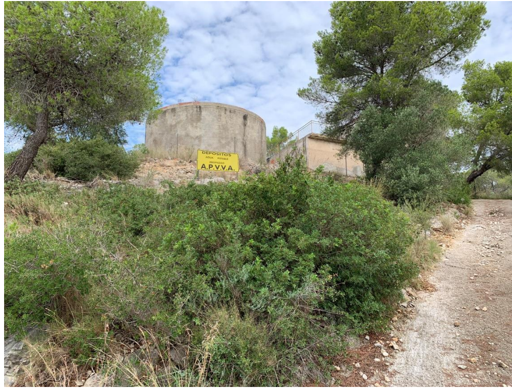
Figura 3: Imatge del dipòsit de Can Lloses
