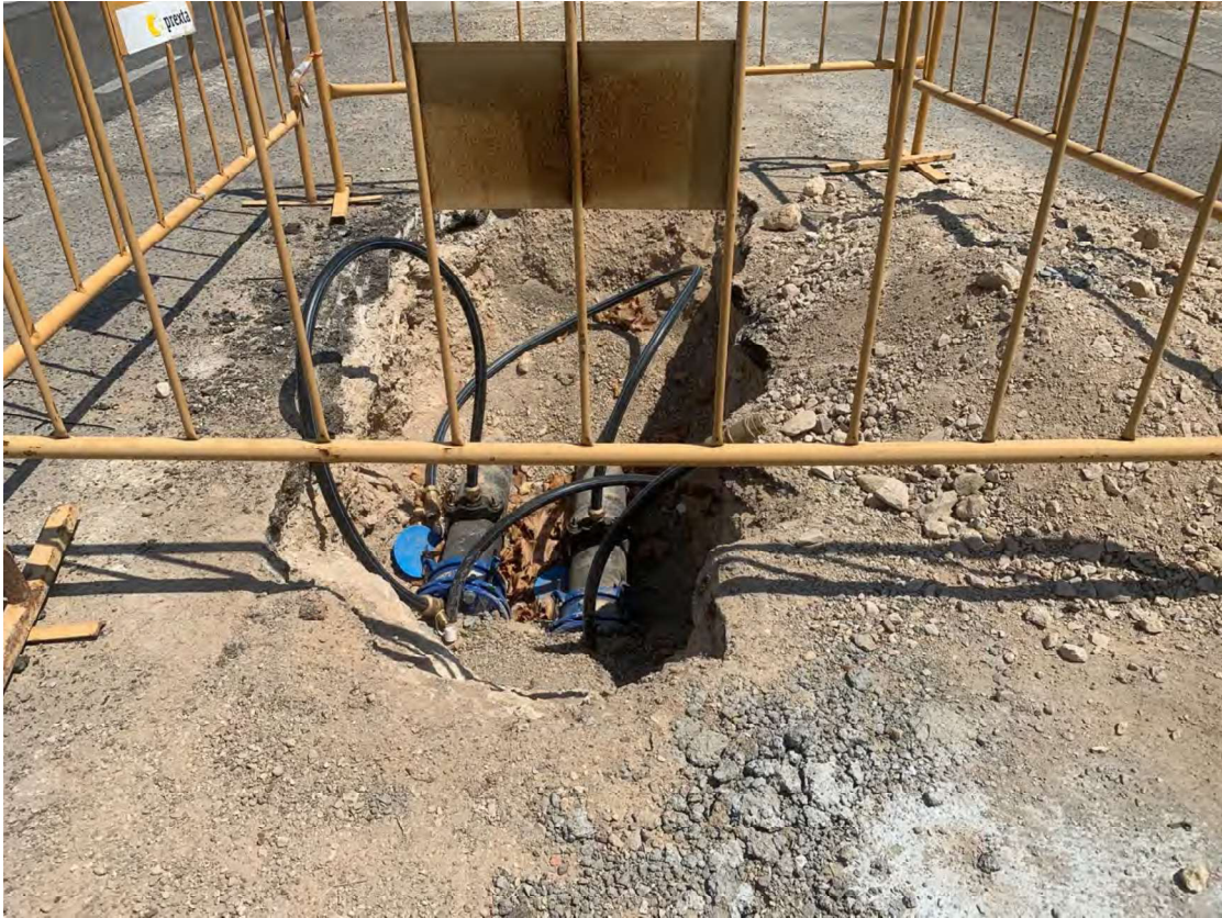
Comprovació a canonades de fosa existents a tram de carril bici a la Ctra direcció Olivella.
