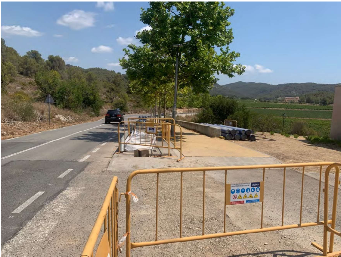
Àmbit d'actuació amb canonades de fosa existents a tram de carril bici a la Ctra direcció Olivella.
