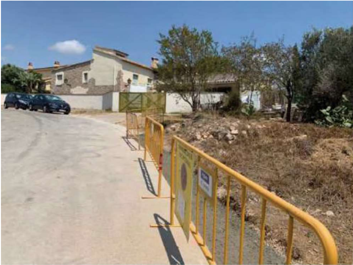
Tapat de la rasa amb formigó previ a l'asfalt
