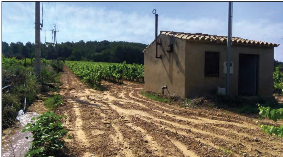
Imatge i29.- Caseta del pou del Sr. Pagès
