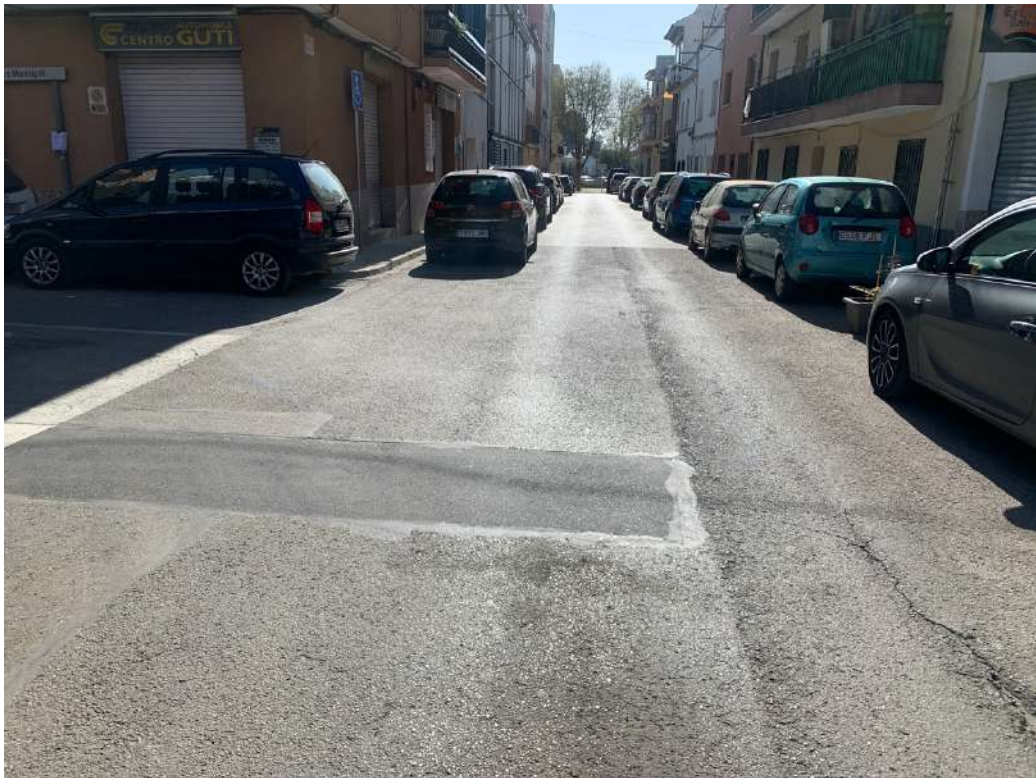
Asfalt malmès al carrer Roger de Flor
