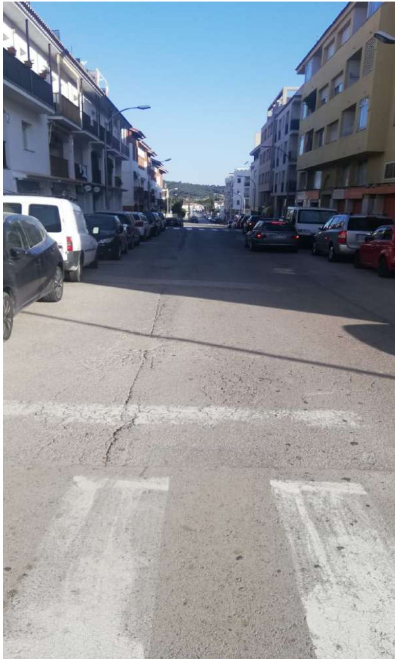
Vista general carrer Ildefons Cerdà
