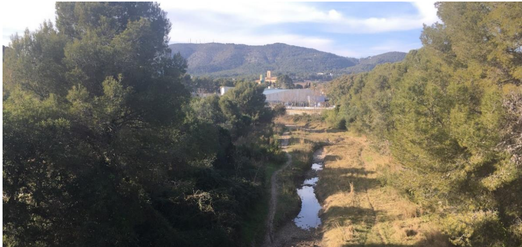
Figura 25. La riera de Ribes vista des del pont de la BV-2113 en direcció nord.
