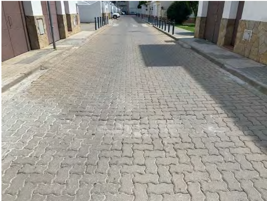
Bombaments al paviment de llambordes
