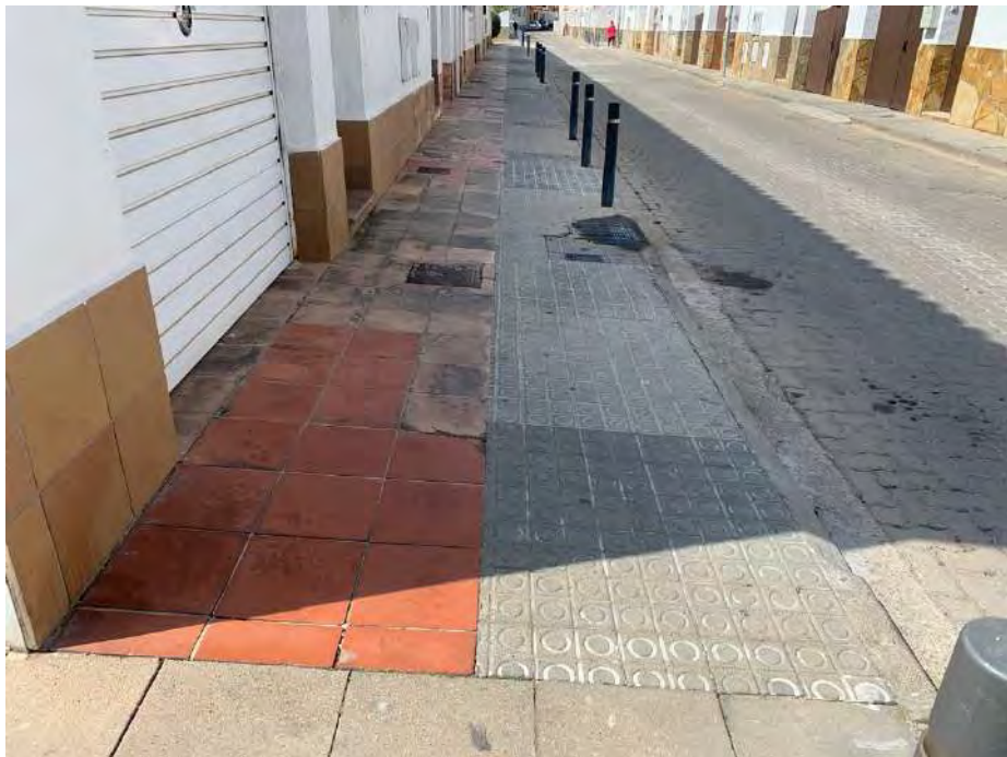
Diferents materials al paviment de la vorera oest
