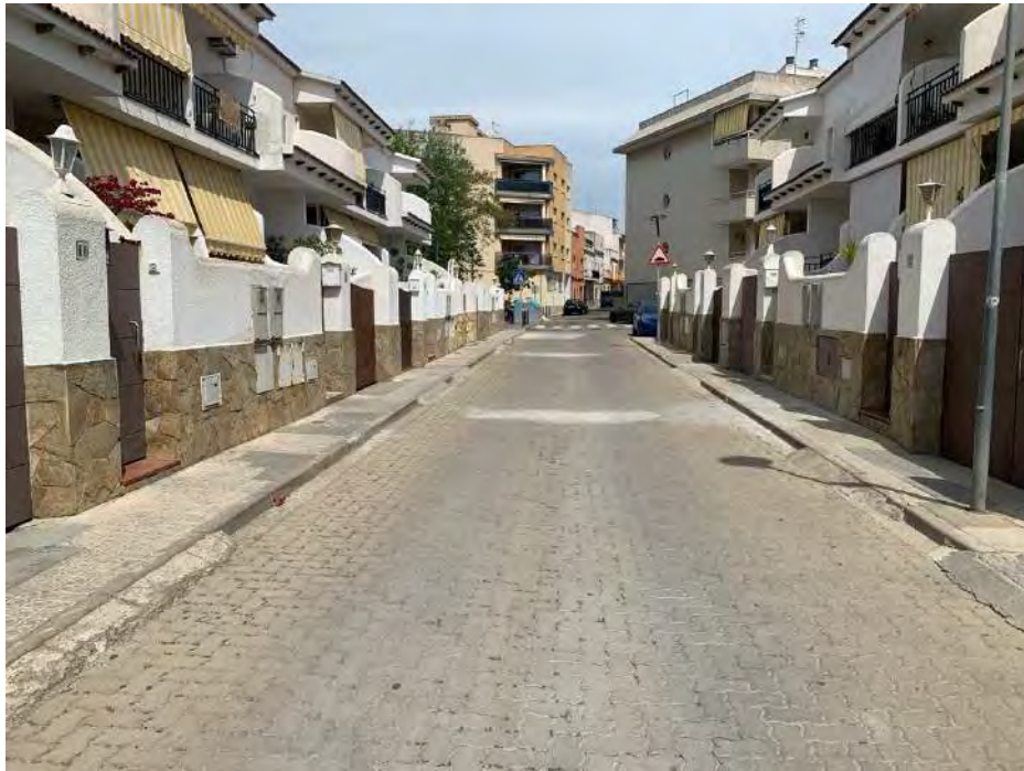
Vista general de vial a intervenir
