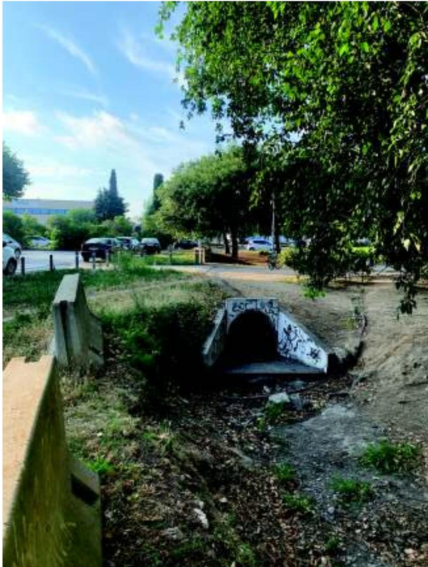
Riera a conduir per canonada continuant el tram soterrat existent.
