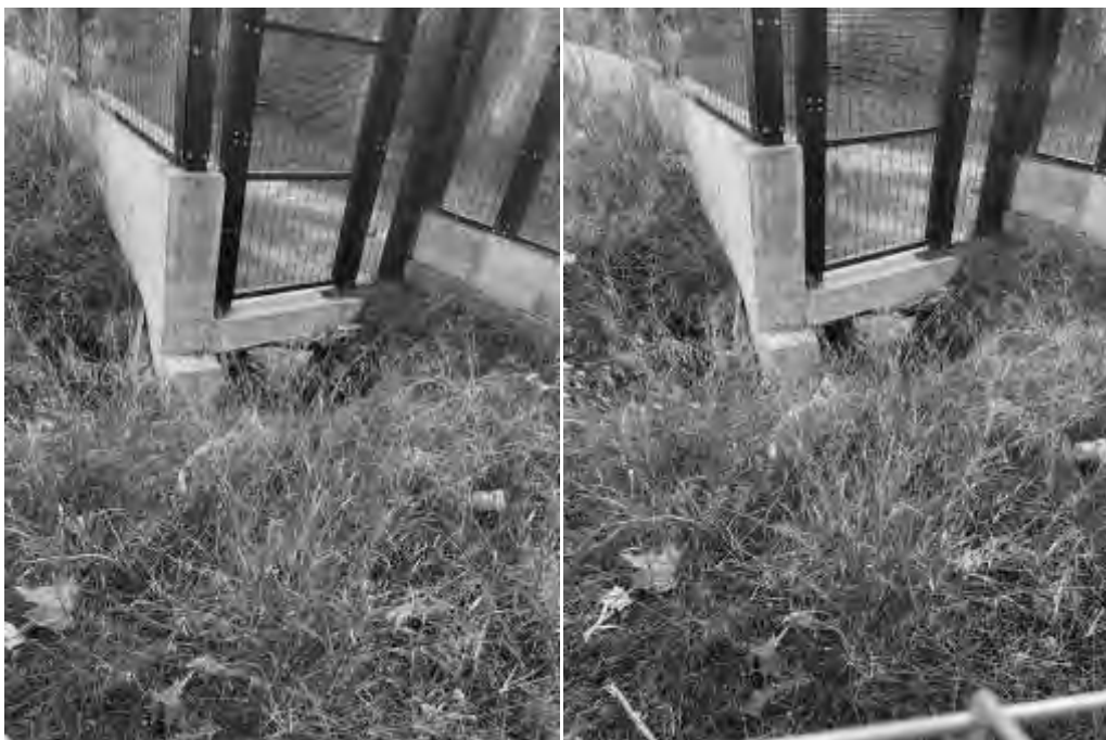
Zona lateral del camp de futbol que dona a la riera que es tancarà amb un mur d'escullera i es col·locarà una nova reixa d'evacuació d'aigües.
