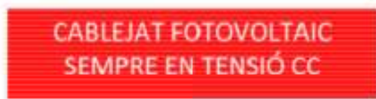
Figura 15. Senyalització cablejat CC. Font: Bombers de Barcelona.
