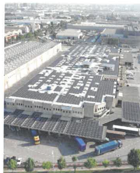
Nau Zona Aduanera, Zona Franca – 2217,6 kWp
