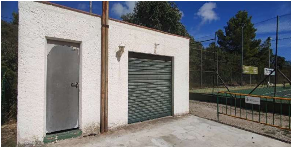
Imatge 9 – Edificació auxiliar on s'instal·laran els equips principals
