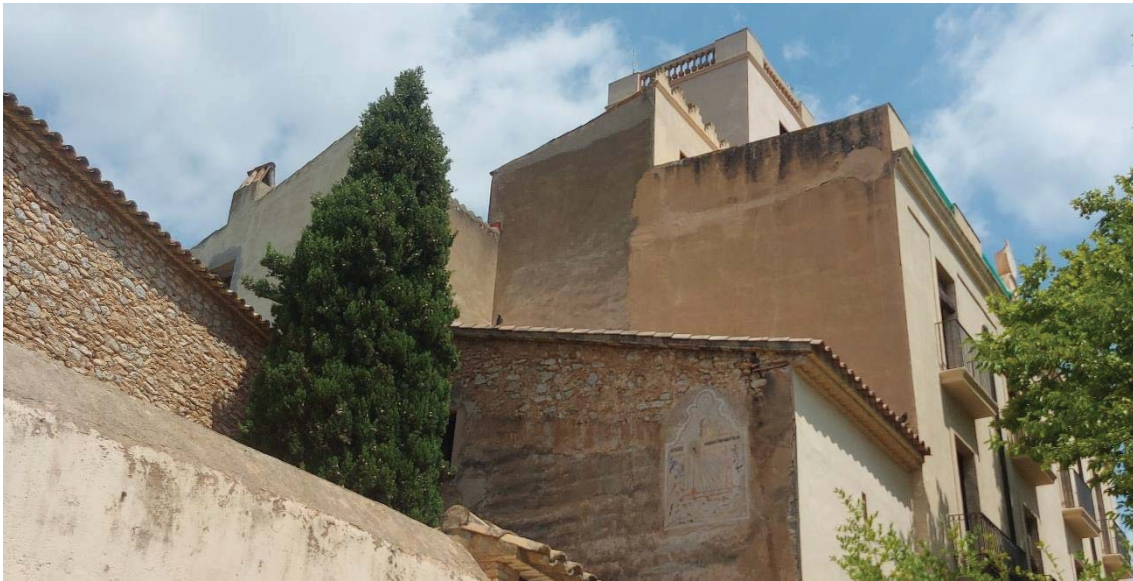
Façana lateral 4 de l'edifici
