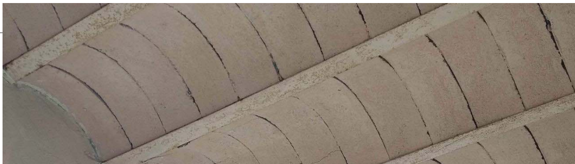
Forjat unidireccional amb biguetes metàl·liques
