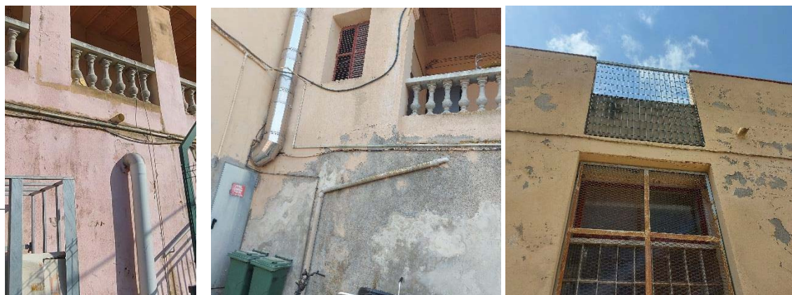
Elements instal·lació evacuació de les aigües
