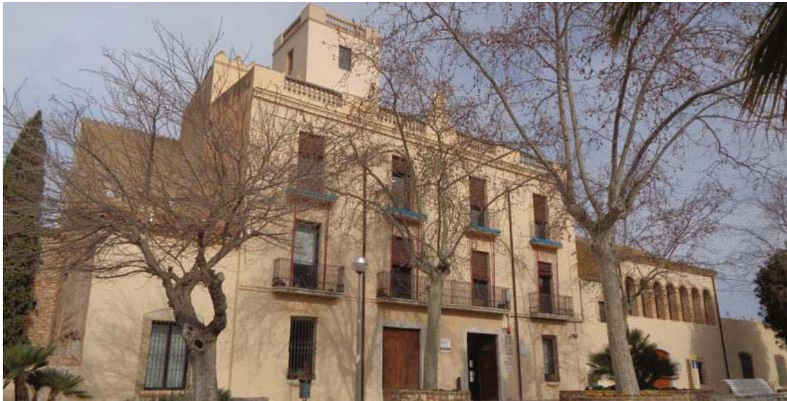
Façana principal del c/ Major.
