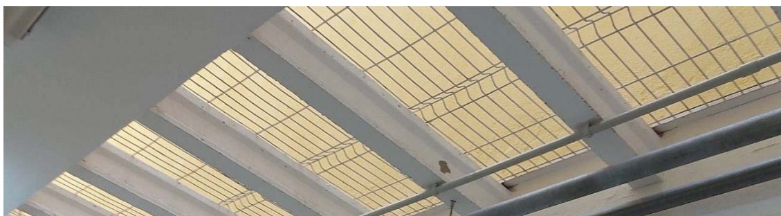
Forjat unidireccional amb biguetes de formigó
