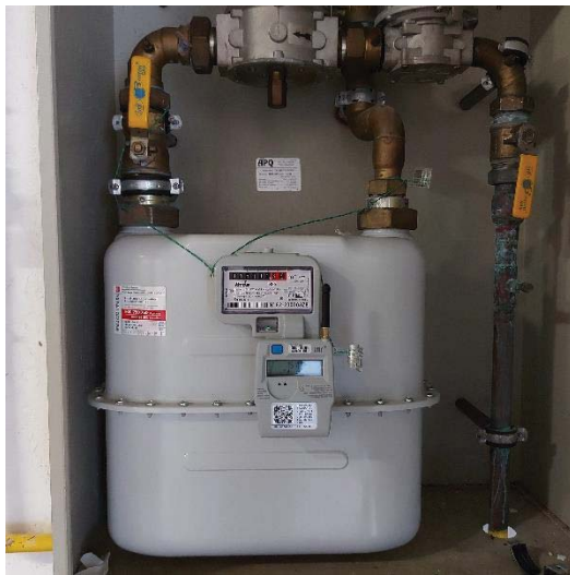
Elements instal·lació de gas natural
