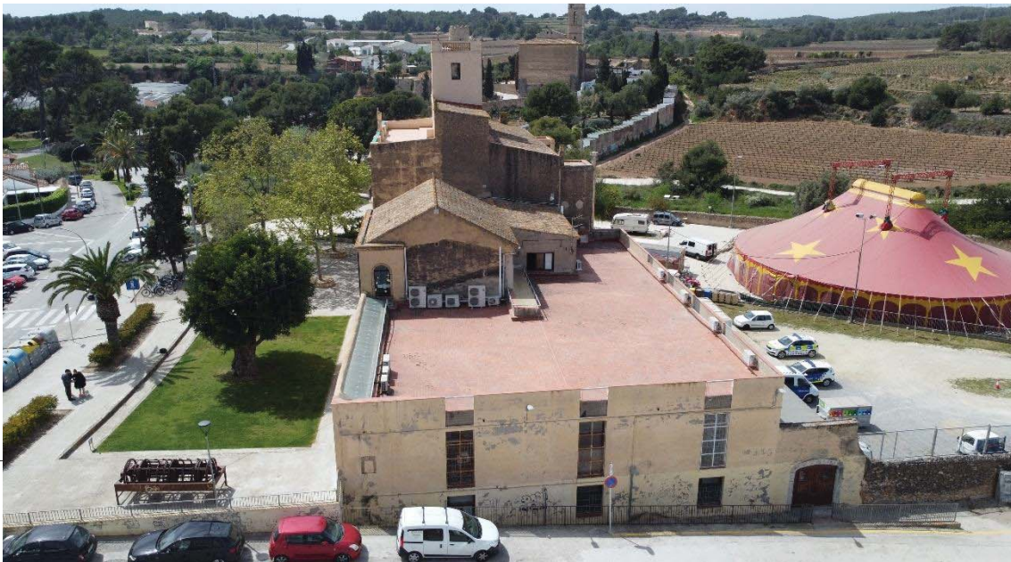
Façana lateral 3 de l'edifici
