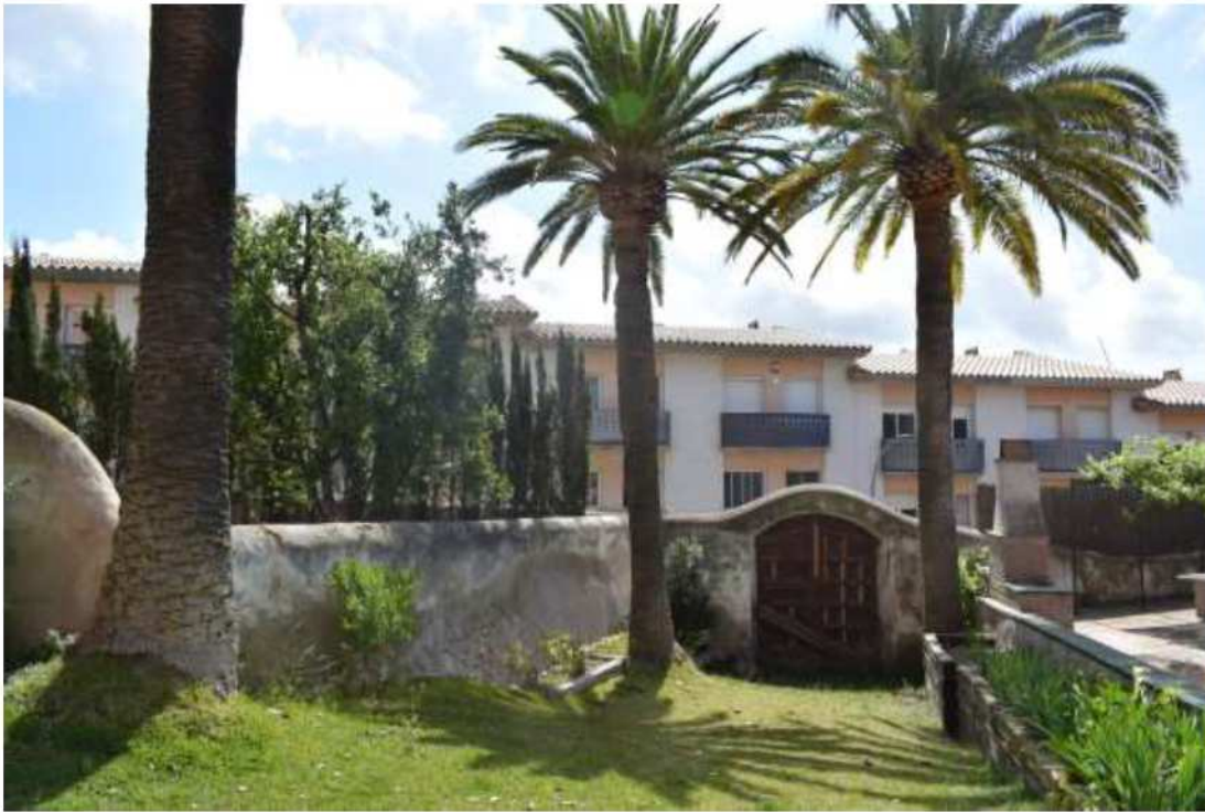
Vista interior de l'accés des del Carrer Narcís Oller, al Sud de la casa i flanquejat per les palmeres. Es troba en dessús des de la dècada de 1980, per causa de la diferència de cota amb respecte de la nova urbanització d'aquest carrer
