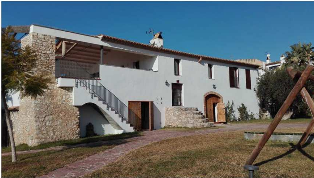
Façana Est de l'edificació auxiliar que havia estat destinada a masoveria
