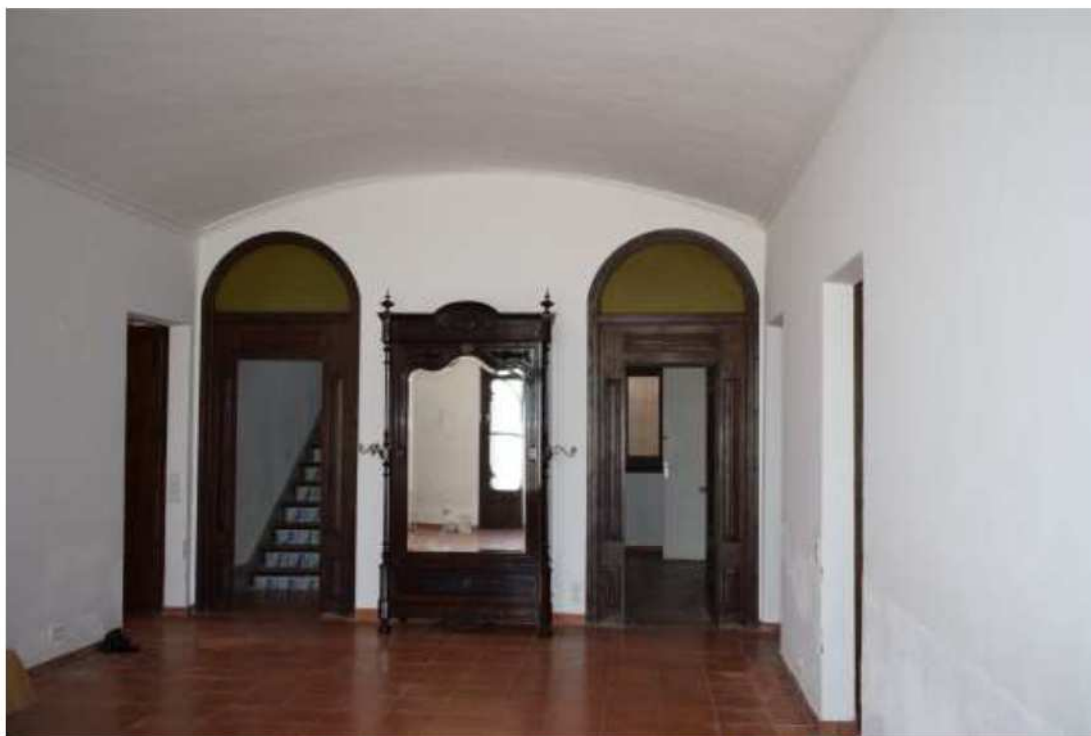
Vestíbul principal. El paviment no és l'original, tot i estar bastant deteriorat a causa de l'acció de la humitat. El mobiliari ha estat aportat pels nous propietaris. Els anteriors se'l van emportar tot.
