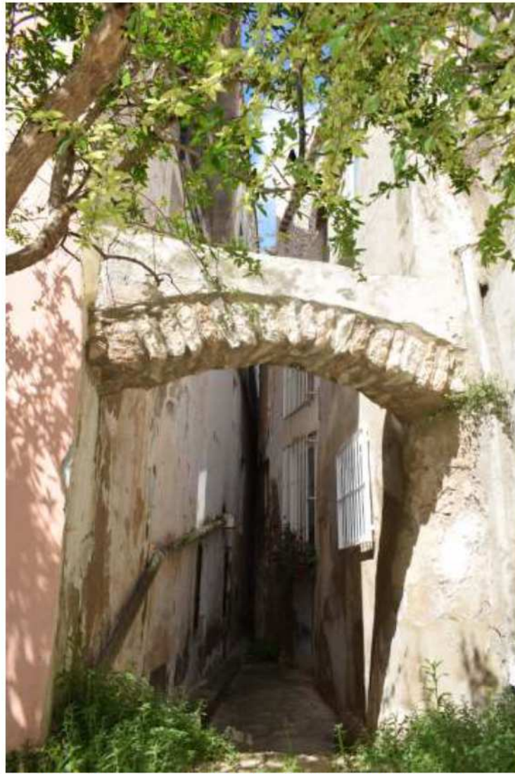
Contrafort entre la façana posterior de "La Granja" i una finca veïna
