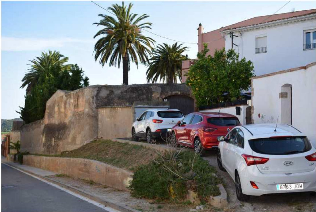
Antiestètica barraca i deficiències en la urbanització, junt als accessos a "La Granja" des del Carrer de Narcís Oller
