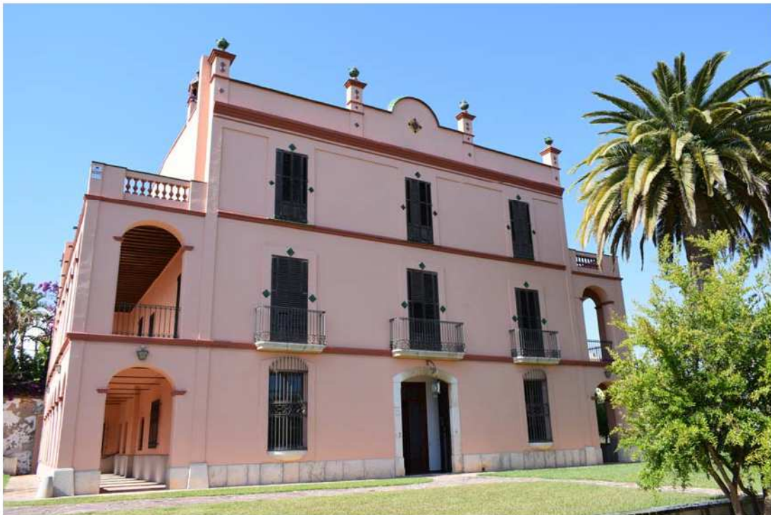
Façana principal, orientada a Sud, o migdia
