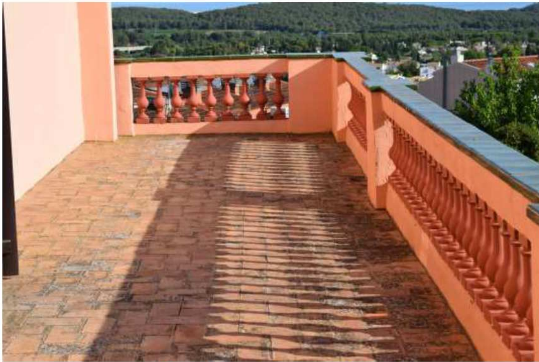
Detall d'una terrassa superior i la seva balustrada
