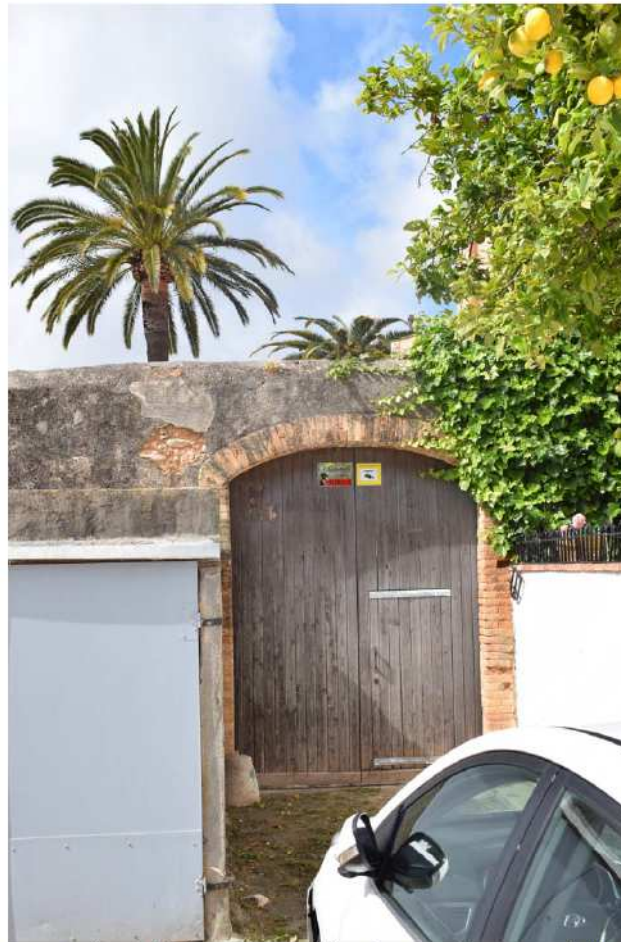
Un altre aspecte de la barraca existent, que ofega un dels accessos al complex de "La Granja"
