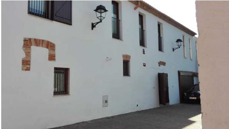
Façana de l'edificació al Carrer del Racó i al passatge
