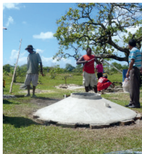
Inici dels treballs.
