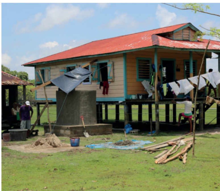
Construcció de sistemes de captació i aprofitament d'aigua.
