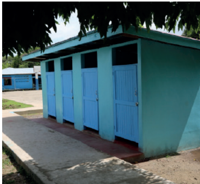
Mòdul sanitari a l'escola.
