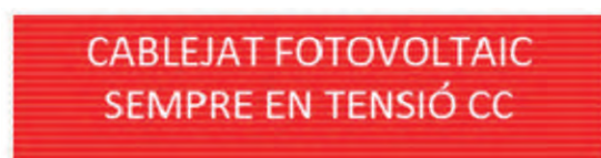
Figura 14. Senyalització cablejat CC. Font: Bombers de Barcelona.
