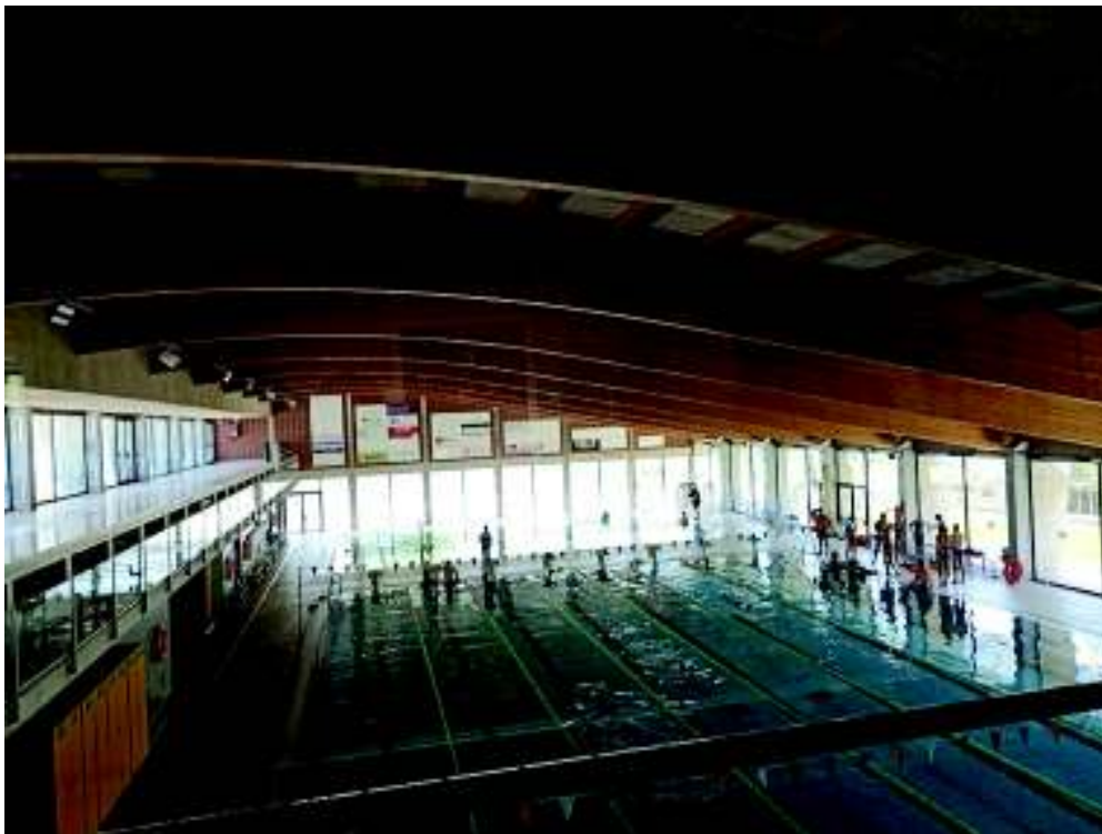
Vista general de l'interior de la piscina i l'estructura de la seva coberta
