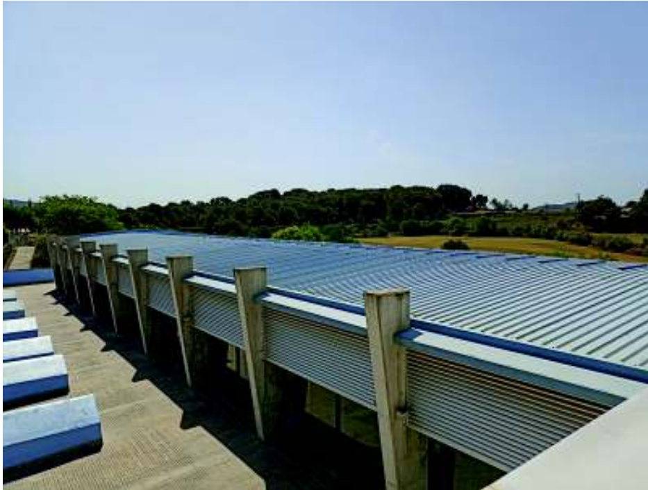
Vista exterior de l'edifici i coberta de la piscina
