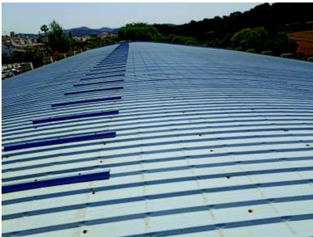
Vista en detall de l'exterior de la coberta de la piscina
