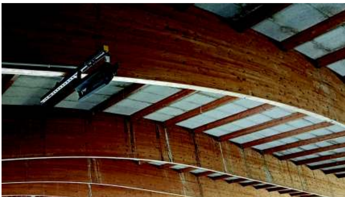
Vista en detall dels recolzaments de les corretges sobre les bigues principals
