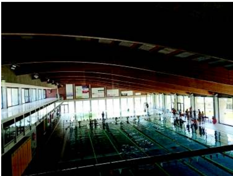
Vista general de l'interior de la piscina i l'estructura de la seva coberta
