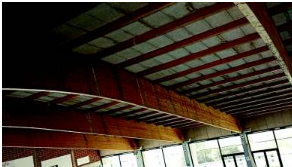
Vista en detall del conjunt de corretges entre dos pòrtics principals
