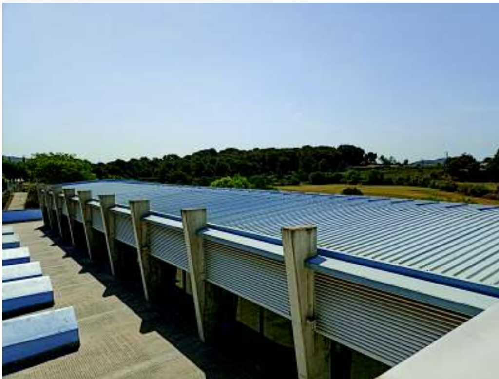
Vista exterior de l'edifici i coberta de la piscina
