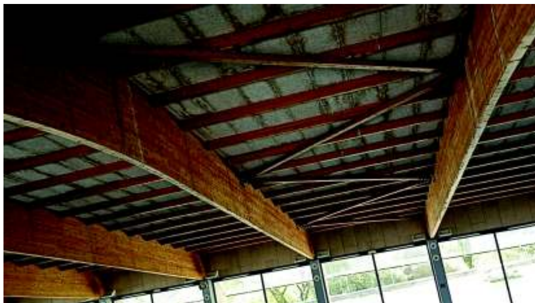
Vista en detall dels arriostaments entre 2 pòrtics principals
