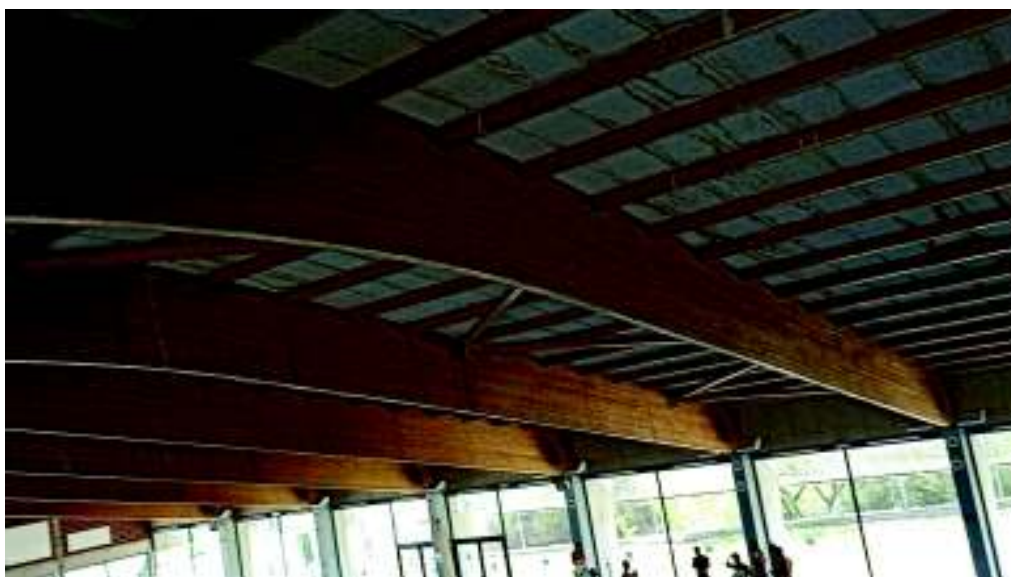
Vista en detall d'alguns pòrtics principals de l'estructura de coberta
