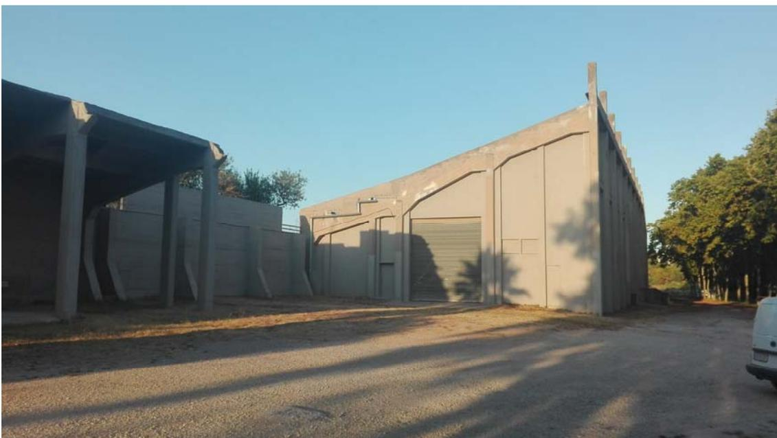
*Imatge de la façana oest de l'edifici principal de les grades. S'observa el perfil de les grades així com els pòrtics de formigó armat que es van repetint en les successives crugies. També es pot observar el tancament executat els anys 60 del s. XX.*
