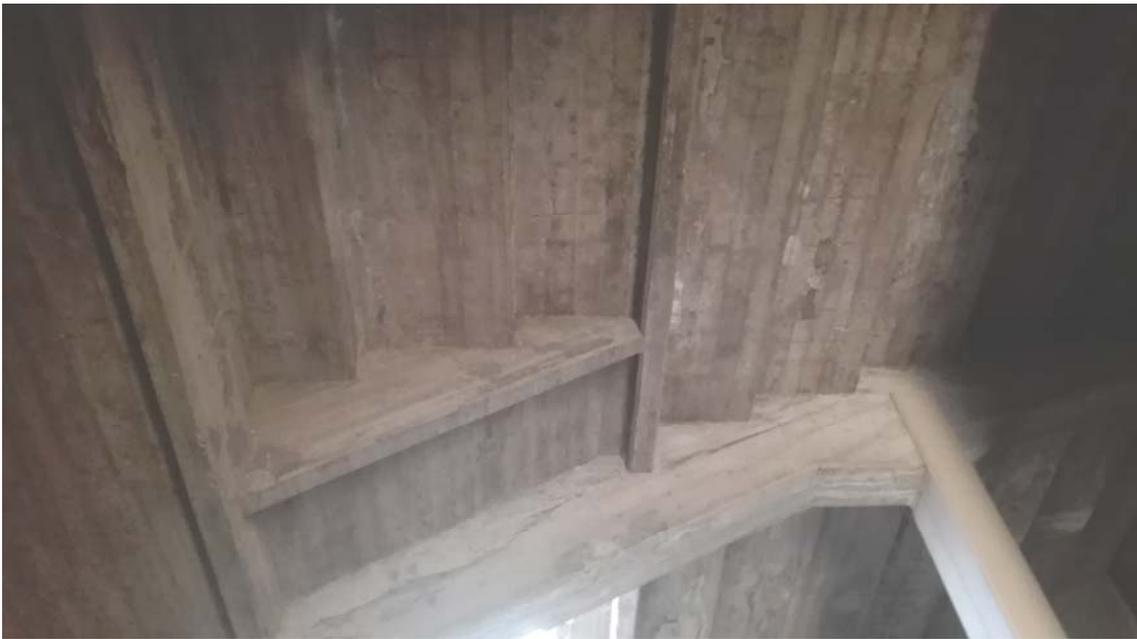
*Imatge de l'interior de l'estructura de formigó. Es pot apreciar el detall dels treballs d'encofrat del formigó armat. També es pot apreciar el bon estat aparent de conservació del formigó.*
