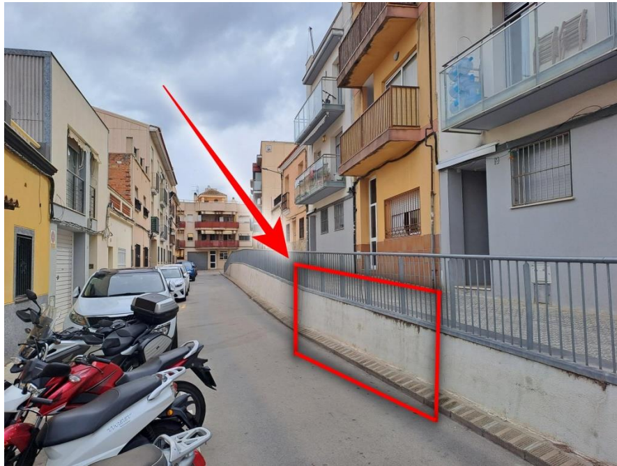
Foto 3: Fotografia actual (sentit nord) amb l'emplaçament aproximat de l'Accés Peatonal amb escala i rampa proposat. Ubicació ideal tot just davant dels números 15 i 17 del carrer Bell-Lloc.
