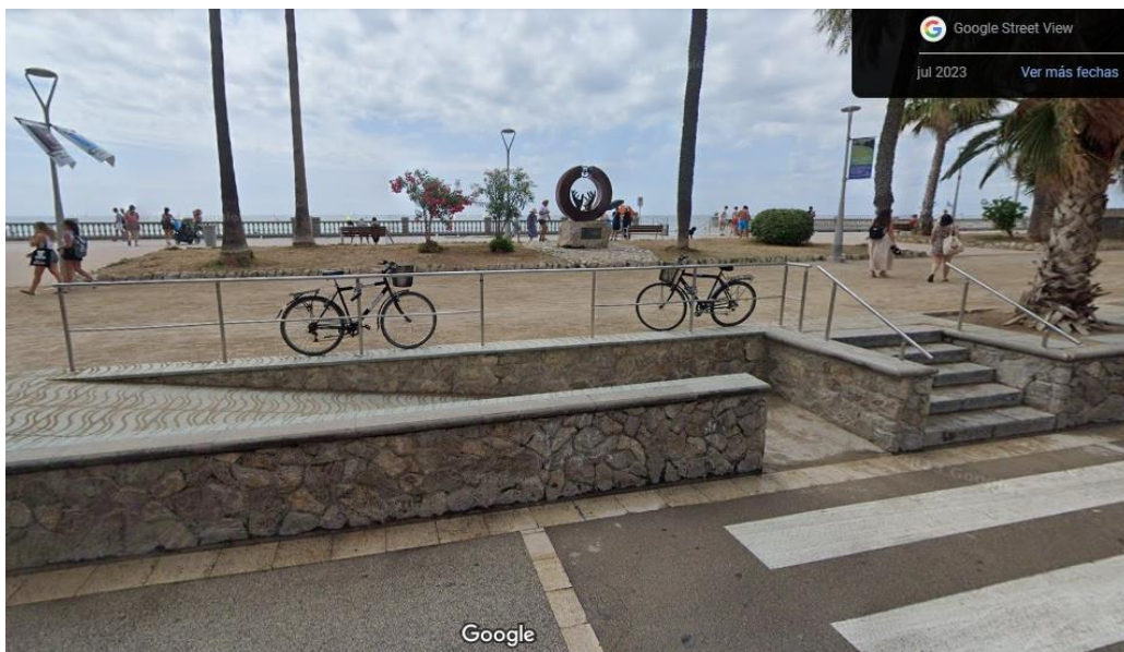
Foto 2: Exemple d'accés peatonal amb escales i rampa com el proposat per al carrer Bell-Lloc (Ubicació: carrer Primer de Maig, s/n, Sitges)
