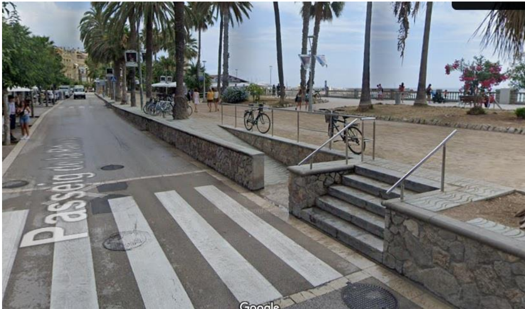
Foto 1: Exemple d'accés peatonal amb escales i rampa com el proposat per al carrer Bell-Lloc (Ubicació: carrer Primer de Maig, s/n, Sitges)
