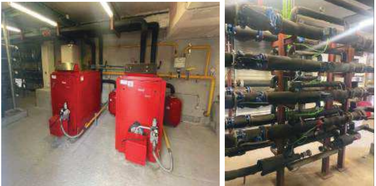
Figura 8:i 9 Calderes i circuits de distribució
