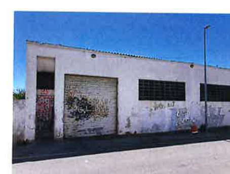
EDIF. PARC. A-6a EXTERIOR
