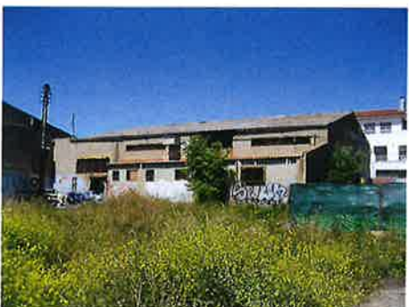
EDIF. PARC. A-6a EXTERIOR
