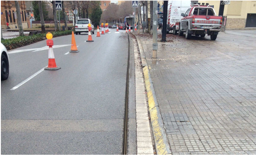
Exemple de canalització de fibra òptica amb microrasa.
