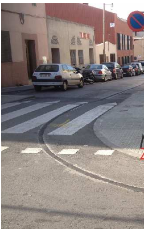
ACABAT DE LA CANALITZACIÓ DE LA MICRORASA
