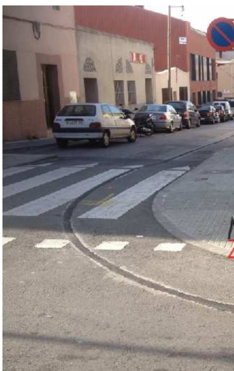
ACABAT DE LA CANALITZACIÓ DE LA MICRORASA
