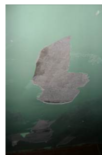
Despreniments forjats planta baixa
