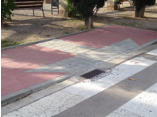
Pas proper de tres rampes
