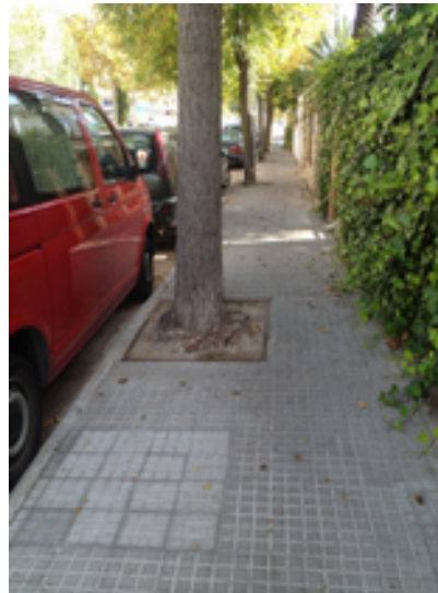
Escocell, reparació puntua de vorera
