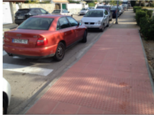
Pas proper de dues rampes
