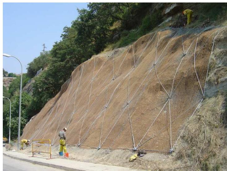
Foto 1: Exemple de talús protegit amb manta orgànica + malla metàl·lica + bulons + cablejat
