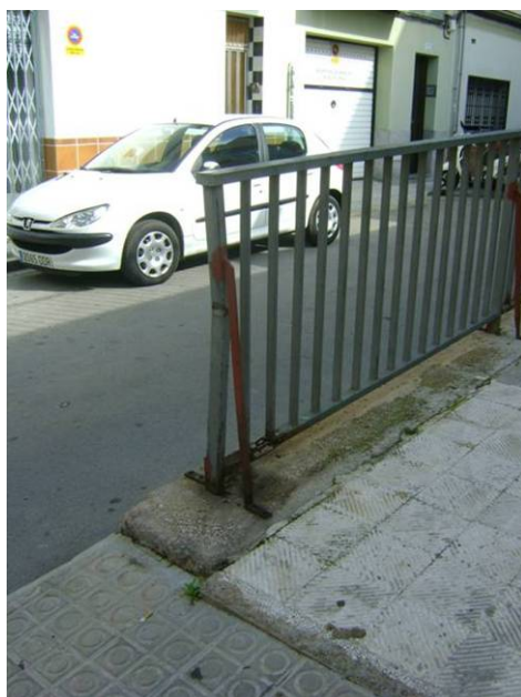
Barana de ferro existent
