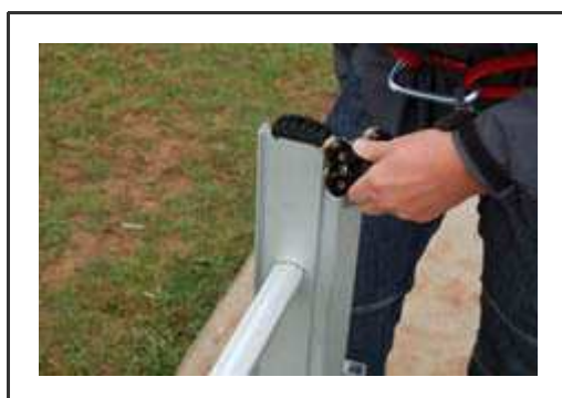
Instalación carro VIA 4 en raíl de escalera Saffeladder®.
