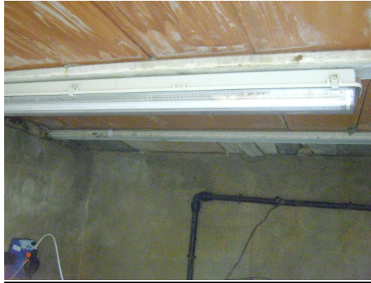
interior de l'espai confinat
