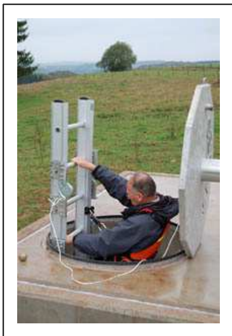
El usuario desciende al pozo permanentemente asegurado contra la caída en altura por la escalera Saffeladder®.
