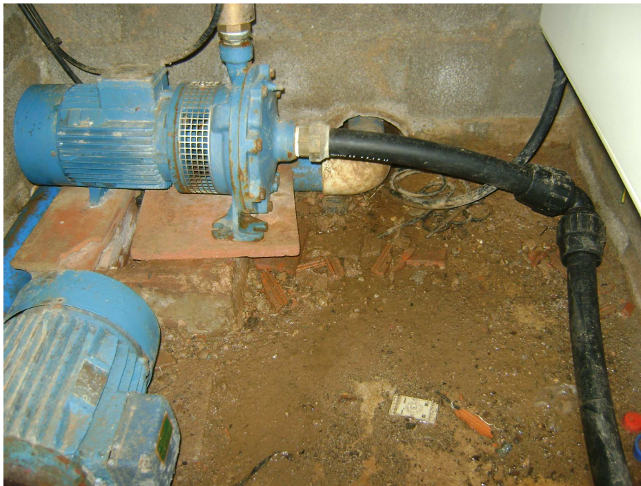
Estat actual de les instal·lacions per la part interior.
