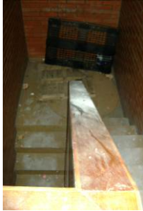
Escales i rampes interiors
