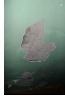
Despreniments forjats planta baixa
