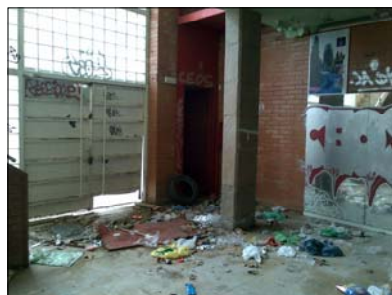
FOTOS UBICACIÓ ASCENSOR
