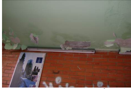
Despreniments forjats planta baixa
