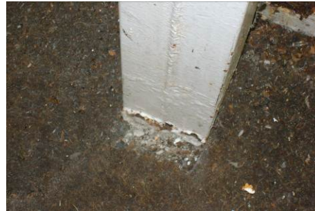
Pilars metàl·lics amb oxidació en la seva part inferior
