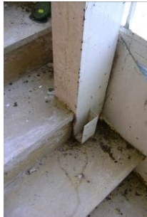
Pilars metàl·lics amb oxidació en la seva part inferior
