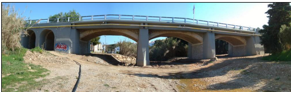
Vista de l'estructura del pont de la ctra. 246a des d'aigua avall
