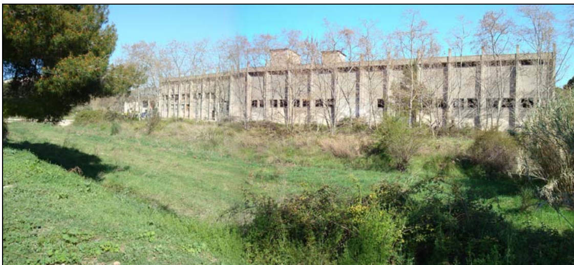
Foto núm. 21. Composició panoràmica de l'edificació previsiblement en desús del Clot dels Frares, en el marge esquerre
