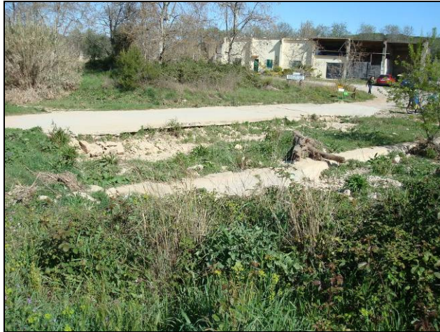
Vista de l'estructura del pont de la ctra.246a des d'aigua avall
