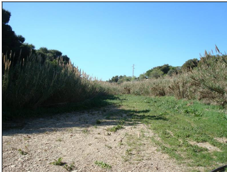
Vista de la llera a l'entorn del pont de la ctra. C-246a
