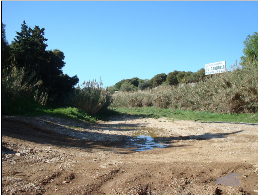
Foto núm. 3. Vista de la riera en sentit aigua amunt des del pont de la carretera C246a
