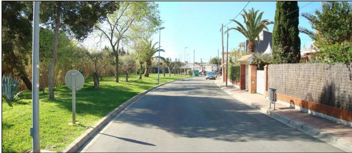
Foto núm. 7. Vista en sentit aigua avall del marge dret en la urbanització Rocamar
