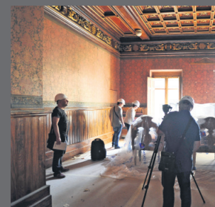
LA SALA, EN OBRES. El govern municipal vol salvar les parets laterals. FÈLIX
