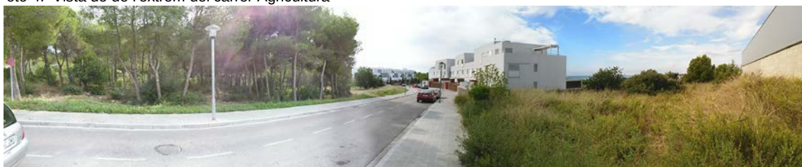
Foto 5: Vista de de l'extrem del carrer Talaia cap a EP-1 i també parcel·la EP-2
